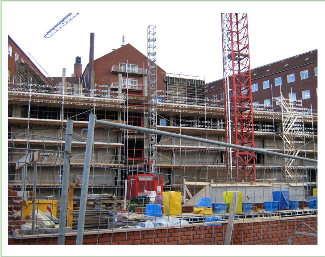
Billede fra byggepladsen for DNC-huset, den 12. marts 2008.
